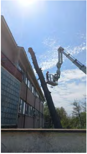
MESSA IN SICUREZZA ALBERATURA - LATO NORD
